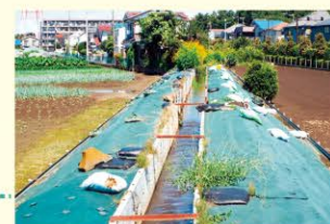
土地の高低差をなくして、用水の水が流れるように土手を作った様子がわかります。
